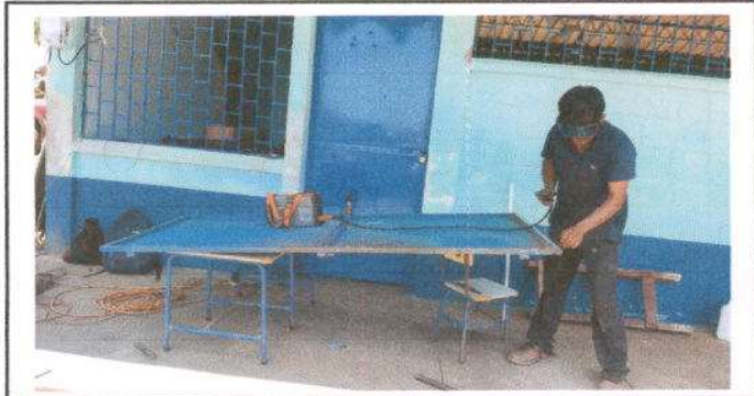
Foto 5: Sustitución de chapa (Puerta 1)
