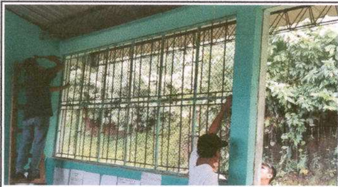
Fotografía 9: Sustición de balcones de metal
