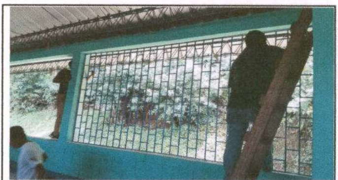
Foto 10: Sustición de balcones de metal
