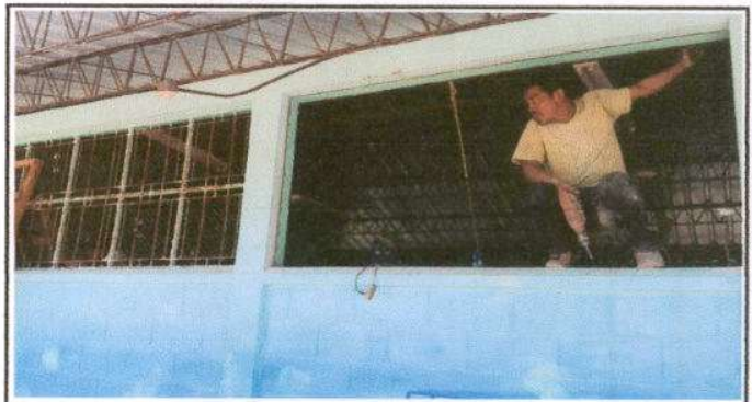
Foto 10: Sustición de Balcones de metal
