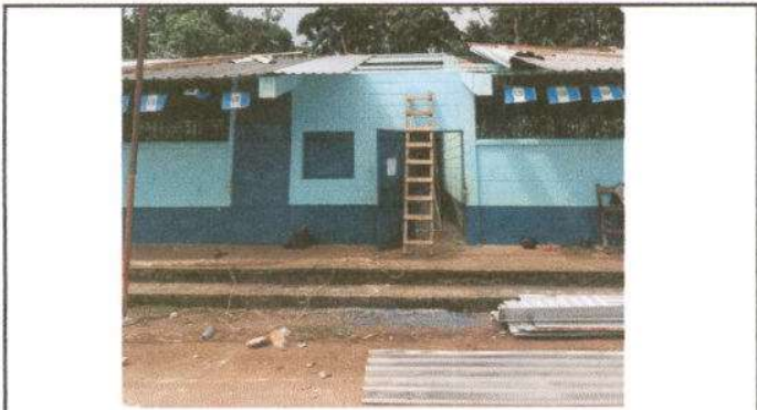
Foto 1: Sustitución de lamina troquelada aluzinc Calibre 26. (Aula 2)
