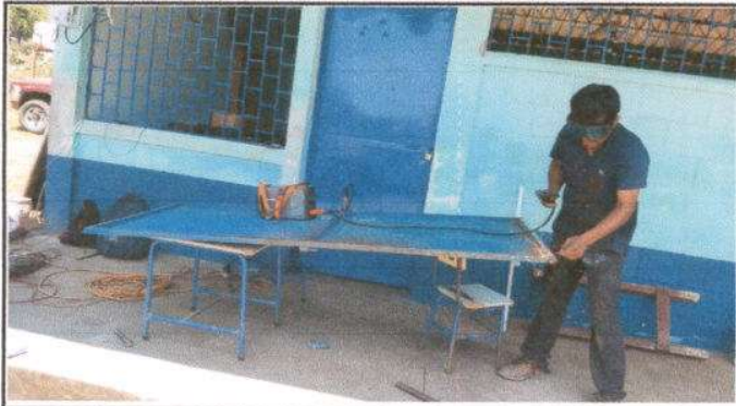
Fotografía 7: Mantenimiento a estructura
