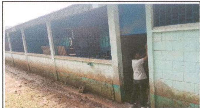
Foto 4: Sustitución de puerta
