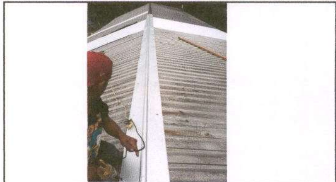
Foto 2: Sustitución de capote y elementos de fijación. (Aula 1)
