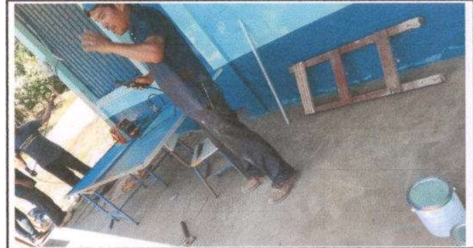
Foto 6: Sustitución de chapa (puerta 2)
