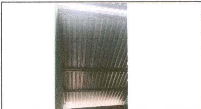
Foto 3: Sustitución de estructura de soporte de manera por metal (Bodega)
