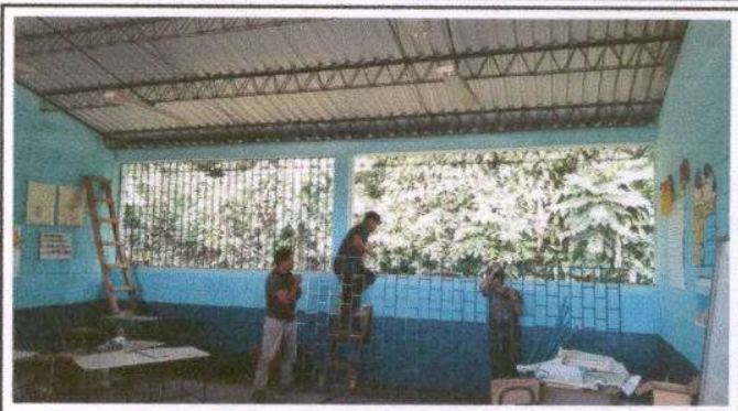
Fotografía 8: Sustición de balcones de Metal
